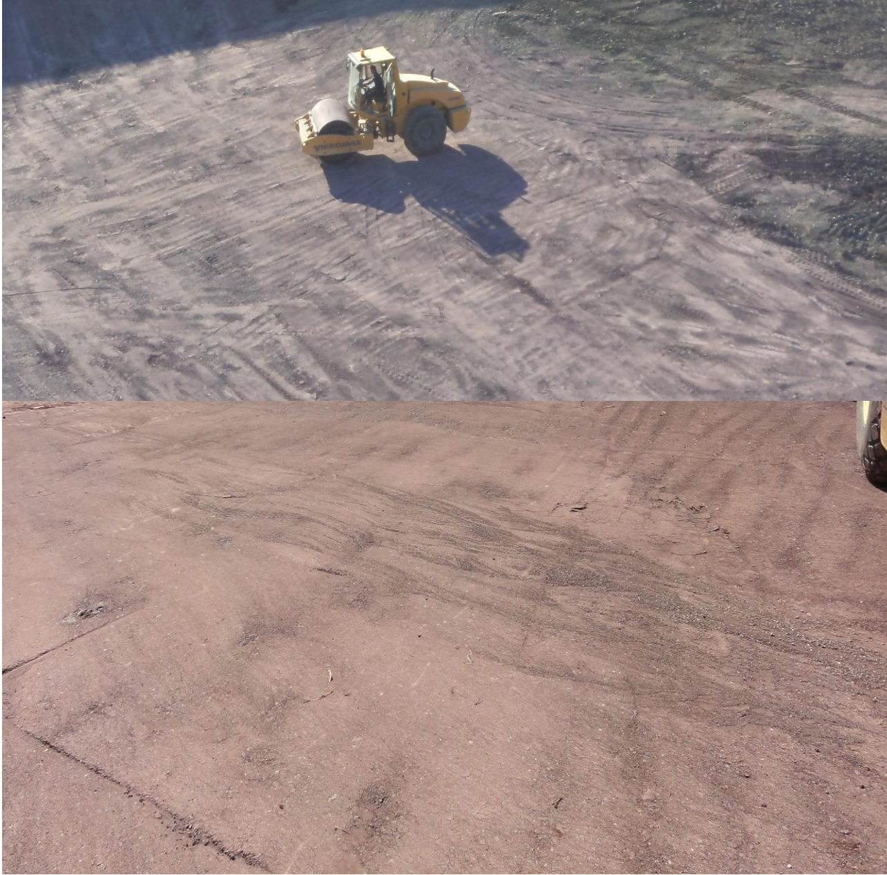
Göl alanına serilen doğal kilin silindir ile sıkıştırılması
