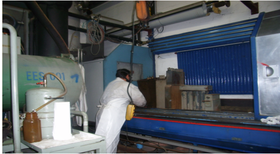
Şekil 27. PCB içeren ekipmanların arındırılması
