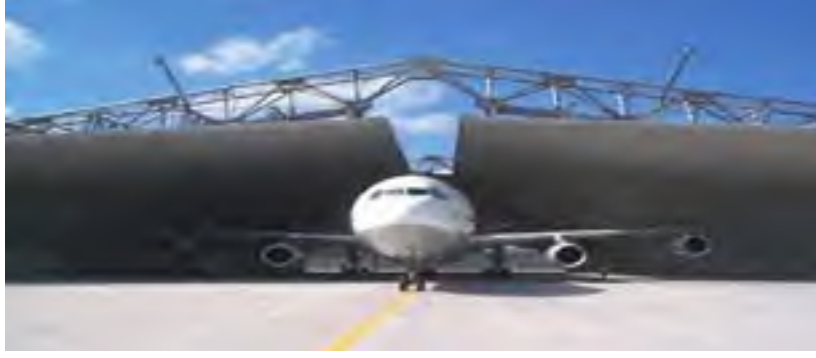
Resim 5-48: Bir hava limanında gürültü hangarı (yarılmış bir çatı uygulaması) [25]
