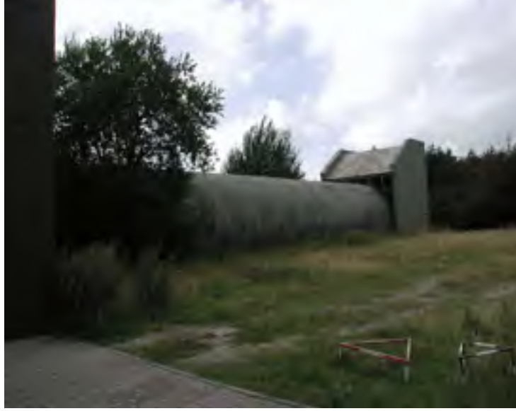
Resim 5-55: Alman Silahlı Kuvvetlerinin motor takımı test sürüşleri için gürültü koruma ekipmanı (atık gaz borusu)
