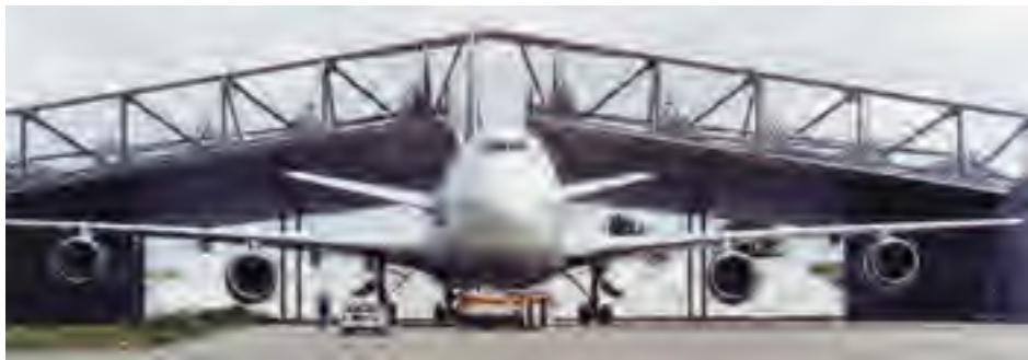
Resim 5-50: Hamburg-Fuhlsbüttel Hava Limanındaki gürültü hangarı (hangar kapısı açık)
