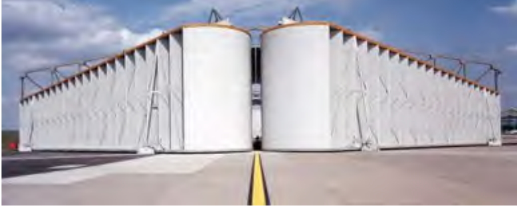
Resim 5-51: Hamburg-Fuhlsbüttel Hava Limanındaki gürültü hangarı (hangar kapısı kapalı)
