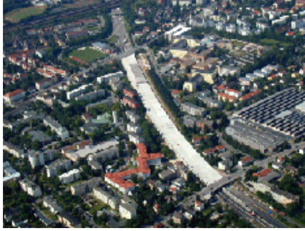
Resim 7-21: Regensburg şehir sahasındaki bir otoyol üzerinin kapatılması
