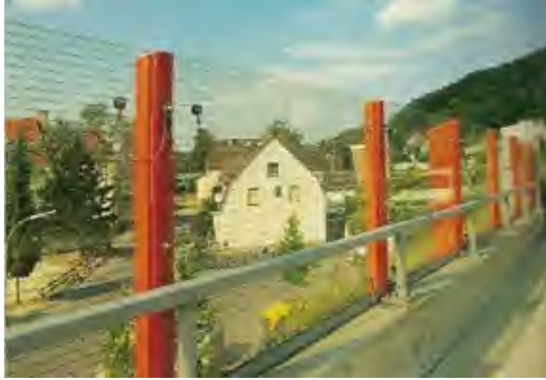
Resim 7-15: Kuş çarpmalarına karşı malzemenin içine işlenmiş şeritlere sahip bir cam perde
